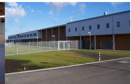
Gebäude mit Werkstätten und Wirtschaftsraum
